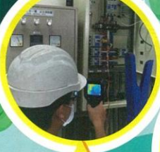
電力盤熱點量測
